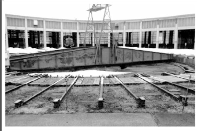
転車台の由来は今から約100年前の1926年京都梅小路機関区で我が国最初に造られ、蒸気機関車(S・L)が一日の役目を終えて、扇形の車庫に効率よく納める為や、方向転換させる目的で考案され、今もS・Lのみならずディーゼル機関車を納庫する際も活躍をしており、当時は人力で回転台(ターンテーブル)を回す為の人員が必要とされたが、今は動力に頼り難くあの重い機関車類を動かしその役目を果たしている。
